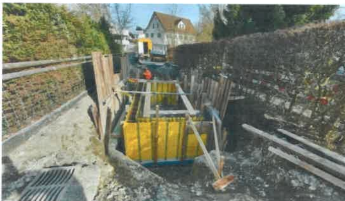
HE 1 im Bau
