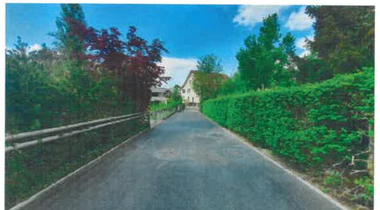
HE 1 nach dem Bau
