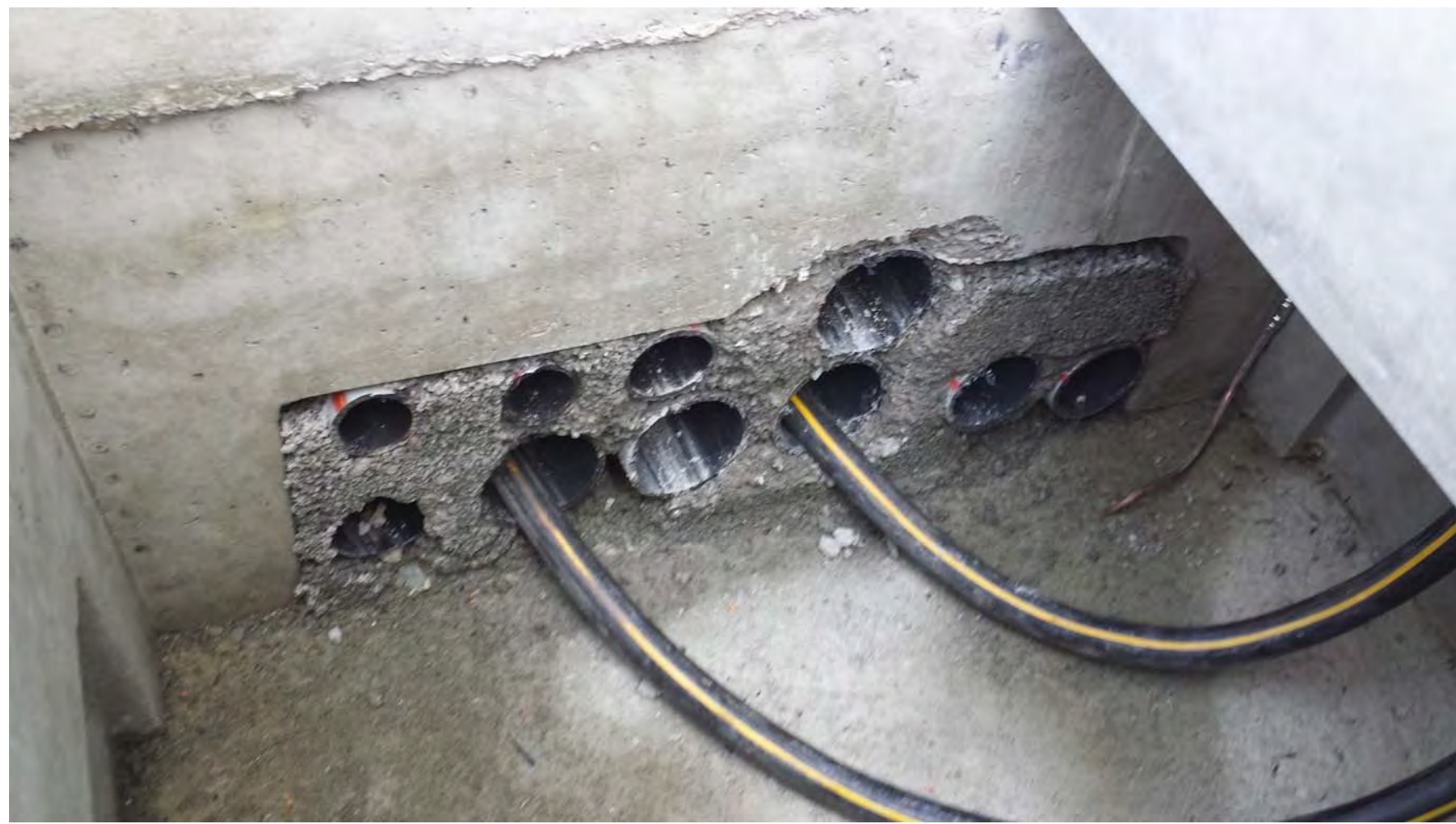
Einmessung EW-Kabel und bauliche Abnahme mit Dokumentation in Feldskizze und Erfassung in der Nachführungs-Datenbank
