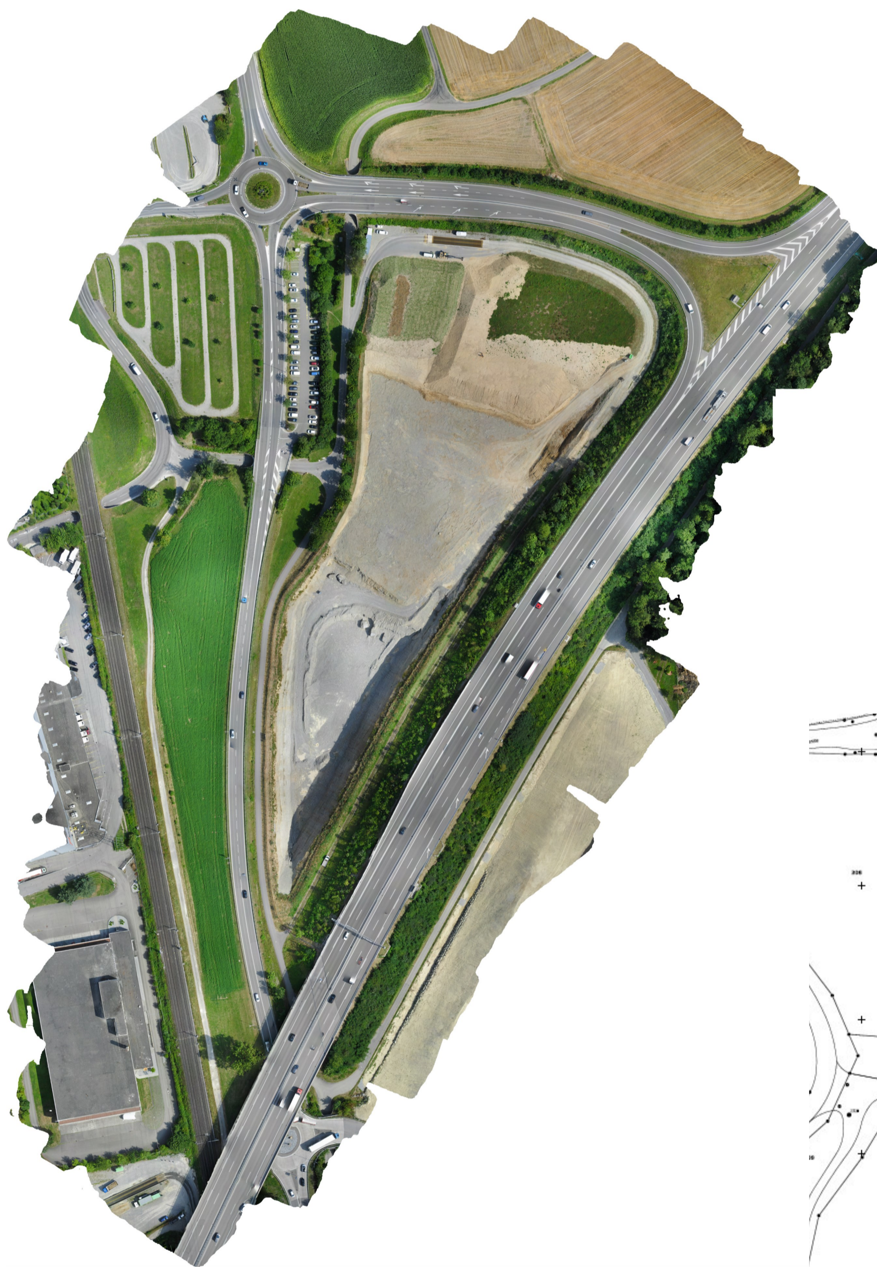
Luftbild der Kiesgrube Brunegg
