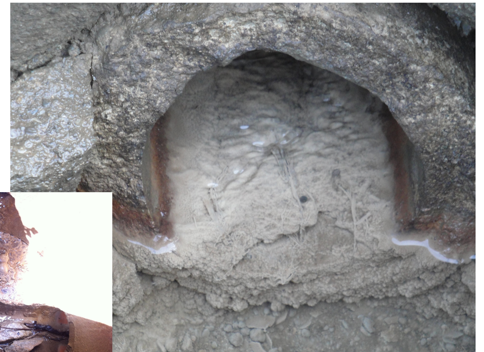
Zustandserhebung der Ableitungen und Schächte
