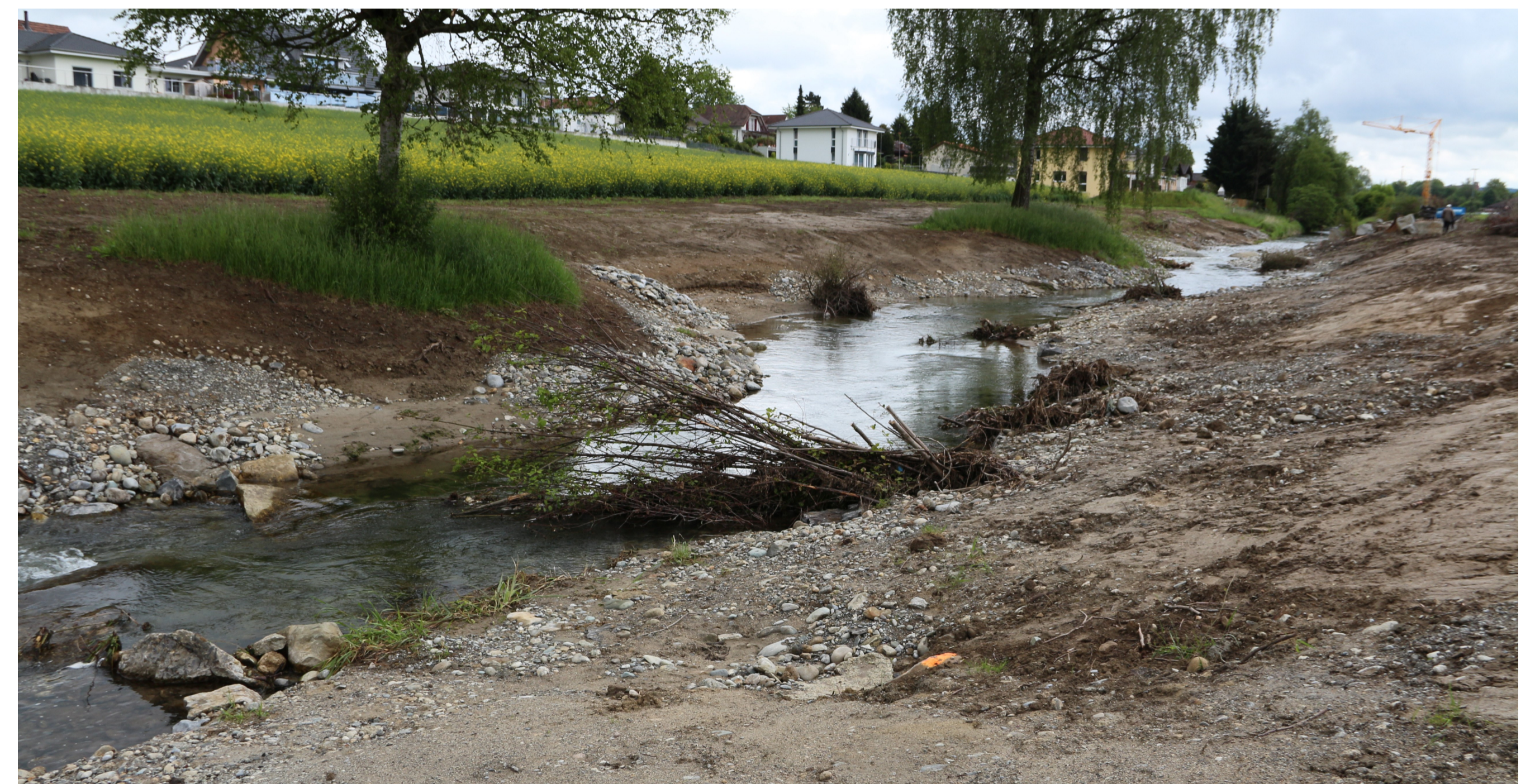
Renaturierter Abschnitt: Keine fixen Verbauungen, unterschiedliche Strömungsabschnitte, Wechsel in Breite und Wasserstand, Kolkbildungen, Fischunterstände durch Baumstämme.
