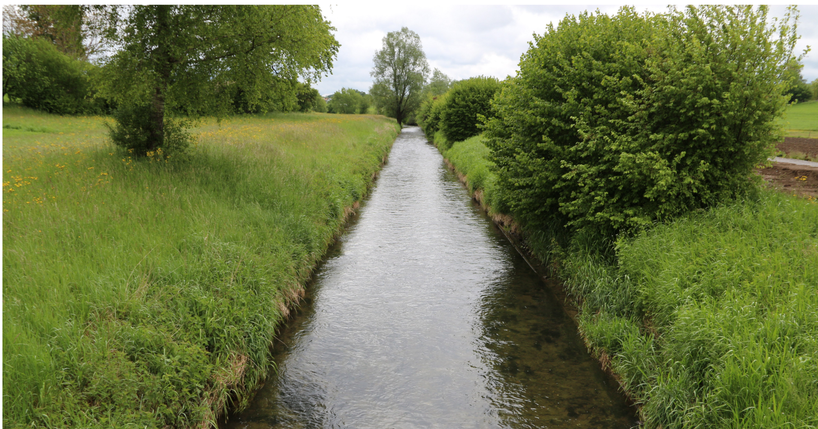
Vor Renaturierung: Begradigt, eintönig, Ränder und Sohle befestigt mit Betonbretter
